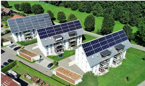
Links: Solarpark Burgdorf: Das erste 100 Prozent solarbeheizte Mehrfamilienhaus wurde 2007 fertiggestellt, zwei weitere folgten 2015. Rechts: Ostansicht des Sonnenhaus Huttwil
