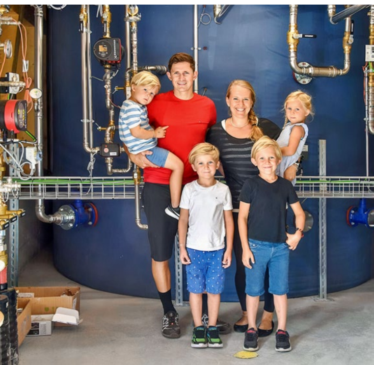
Stolze Eigentümerfamilie vor dem Speicher mit einem Energieinhalt von 1650 kWh in einem Geflügelhof.
