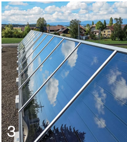
1 Haus 2 in Huttwil, Stand Februar 2023 2 Boden und Mantelteil für Energiespeicher mit Durchmesser über 4 Meter 3 Solarthermieranlage auf Flachdach in Lyssach BE
