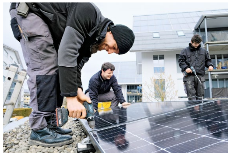
Montage der Photovoltaikanlage Lochbachstrasse 42.
