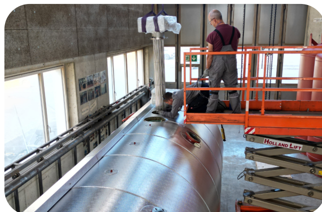
Einsetzen eines Elektroeinsatzes zur Verwendung von überschüssigem PV-Strom mit einer totalen Leistung von 720 kW
