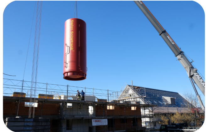
Bild Speichereinbringung in Huttwil am 5. März. 2025
