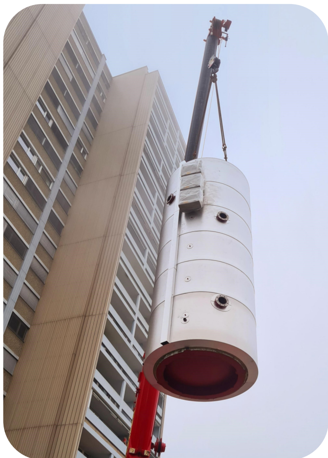
Einbringung des Speichers mit Funktion für die Verwertung von überschüssigem PV-Strom
