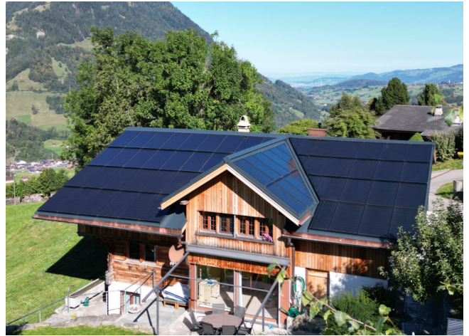
Dach mit Photovoltaik und thermischer Solarenergie
