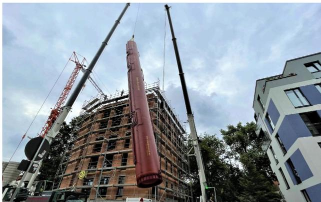
Sechsstöckiger Tank (19 Meter) für sechsstöckigen Solarturm
