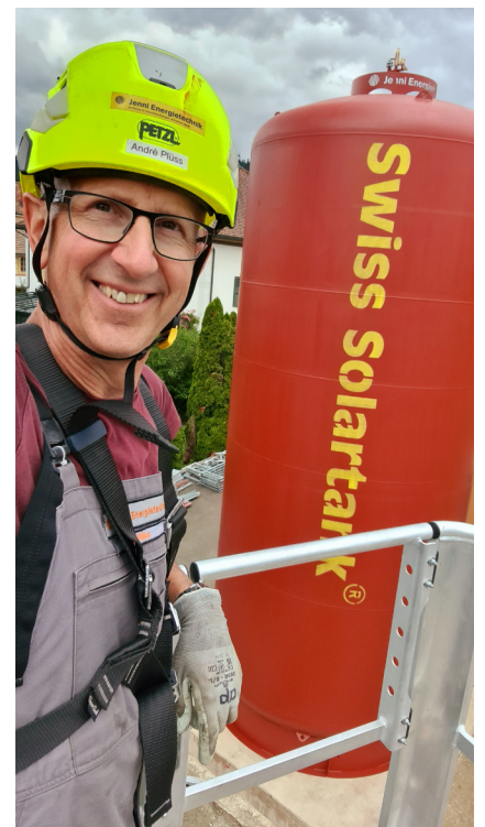
Einbringung des Grossspeichers in Couvet
