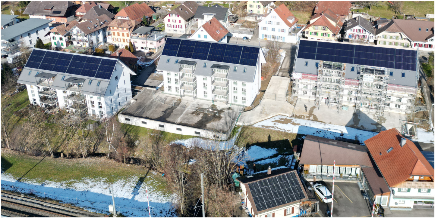
Baufortschritt Haus 2 und 3 in Huttwil stand 19. Januar 2026
